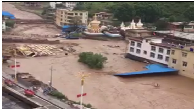
Hochwasser in Jomda, Anfang Juli 2017
